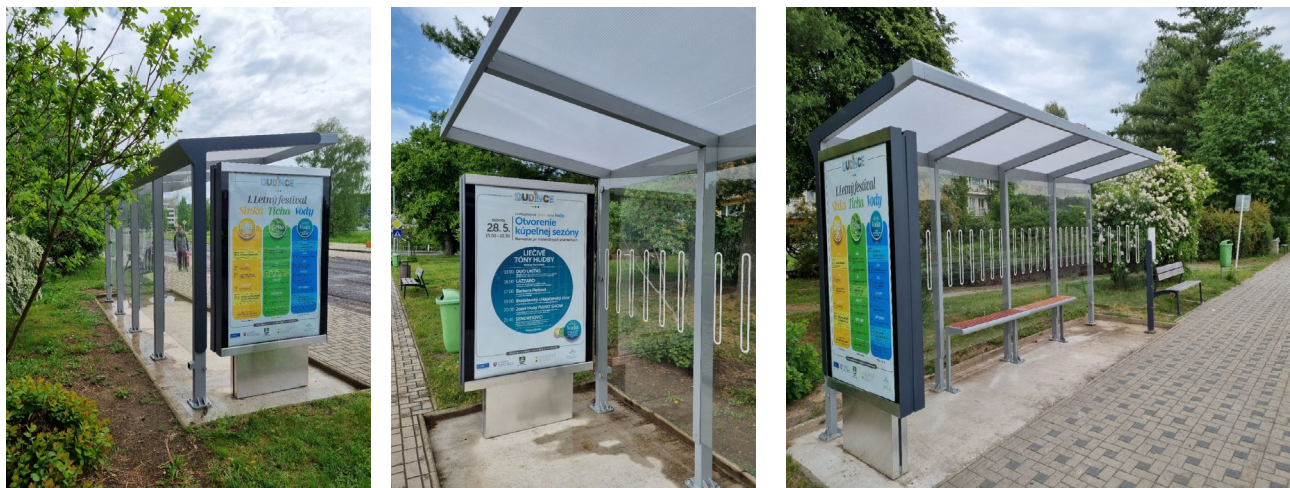
Obr.21-22-23 Autobusový prístrešok so citylightom – foto pred montážou lavičiek
